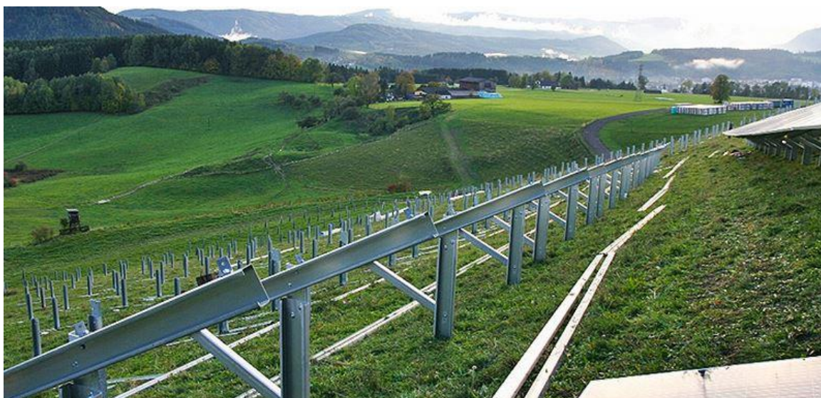
Zdjęcie 3 Konstrukcja przeznaczona do posadowienia paneli fotowoltaicznych.
