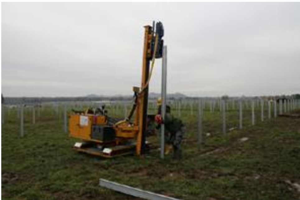
Zdjęcie 2 Montaż profili za pomocą kufara.
