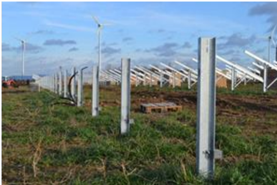
Zdjęcie 1 Profile metalowe: podstawowy element konstrukcji.
